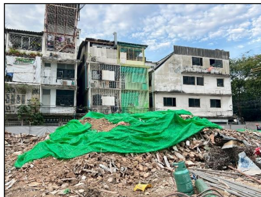
ภาพที่ 18 พื้นที่กองเศษวัสดุจากการรื้อถอน พร้อม ผ้าใบปิดคลุม
