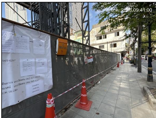
ภาพที่ 13 Mesh Sheet บริเวณด้านหน้าโครงการ
