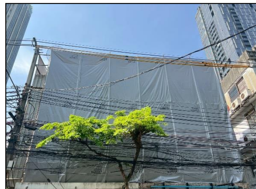
ภาพที่ 14 Sound Barrier
